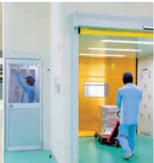
エアシャワー・クリーンルーム
