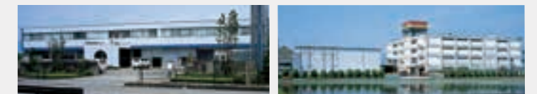
中工場 【生産品目】 商業印刷物、出版印刷物 【土地面積】 7,164m 2 【建物延べ面積】 7,367m 2 西工場 【生産品目】 商業印刷物、一般・連続伝票、パッケージ、シール 【土地面積】 7,367m 2 【建物延べ面積】 8,839m 2
