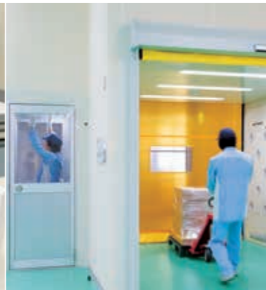
エアシャワー・クリーンルーム *空気中の微粒子がどの程度少ないかを示す規格
