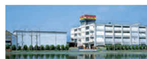
西工場 【生産品目】商業印刷物、一般・連続伝票、 パッケージ、シール 【土地面積】7,367m 2 【建物延べ面積】8,839m 2
