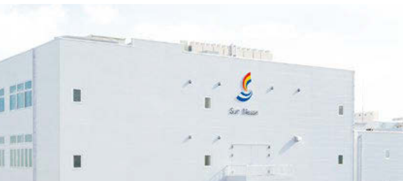
増築が完了した本社第五工場
