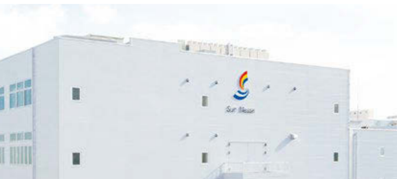
増築が完了した本社第五工場
