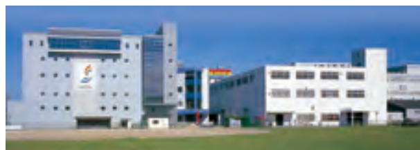
岐阜本社・本社工場【生産品目】商業印刷物、出版印刷物およびデータプリントサービス、パッケージ 【土地面積】34,724m 2 【建物延べ面積】36,914m 2
